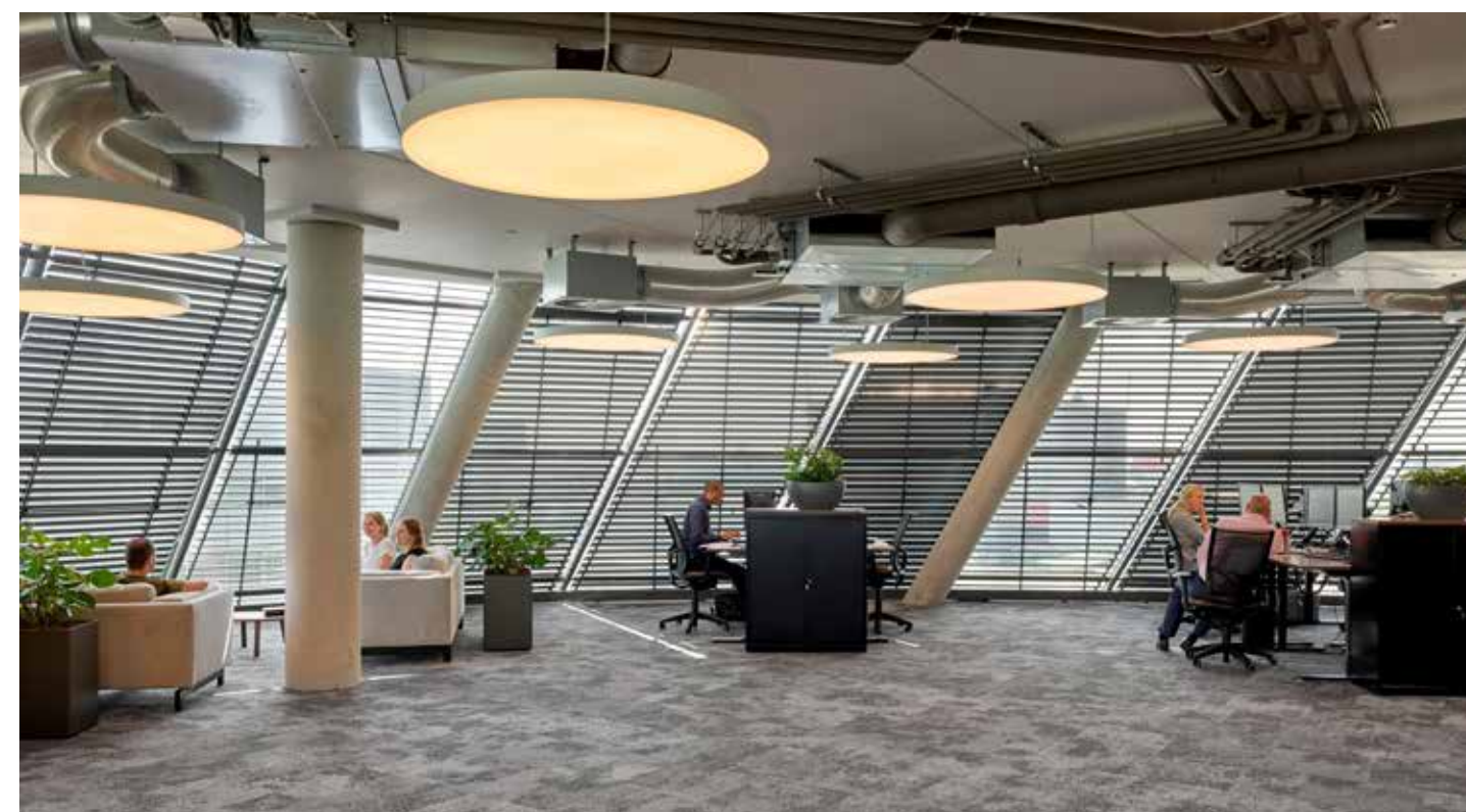
Bij het kantorencomplex The Curve Amsterdam is ieder raam en dus ook het lamellensysteem uniek; niet alleen in dimensies, maar ook qua hoeken en helling.
